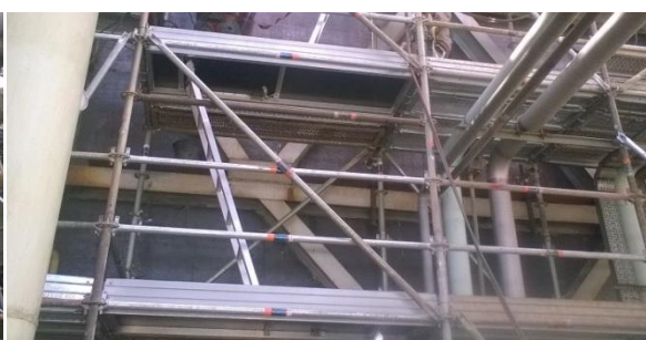
2 MONTAJE DE LA TOTALIDAD DE CHAPA LADO EXTERIOR
