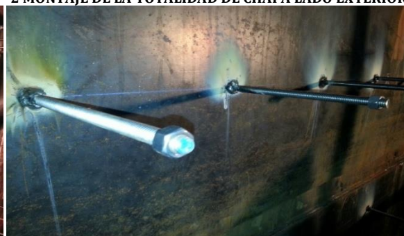
4 SOLDADO DE VARILLAS PARA MONTAJE DE CHAPAS LADO INTERIOR
