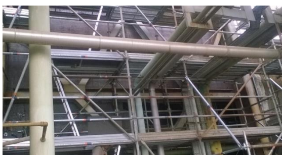
1 INICIO DE MONTAJE DE CHAPA NUEVA
