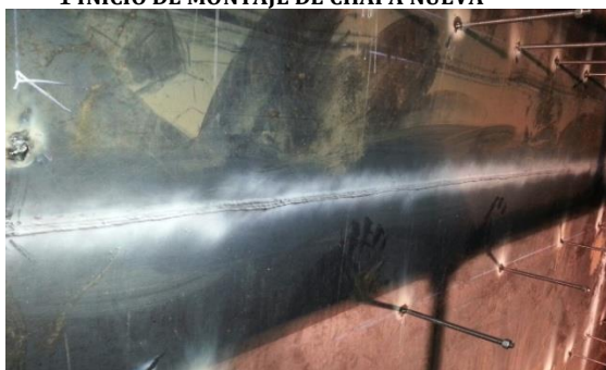
3 SOLDADURA DE CHAPAS CON CHAPA LADO INTERIOR
