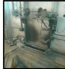
DESAMONTAJE COMPUERTA Y CONTRAPESOS DE HORNO AUSTENIZADO
