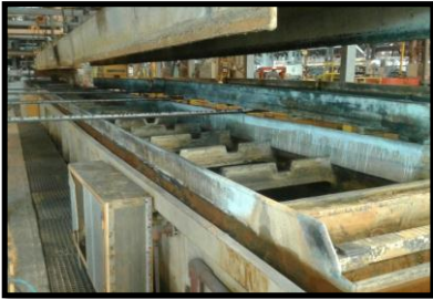
DESAMONTAJE DE PILETA DE ACIDO
