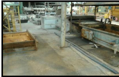
DESAMONTAJE PILETA FLUX
