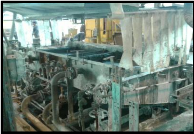
DESAMONTAJE DE PILETA DE SODA
